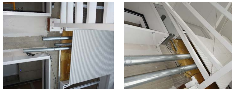
Façade double-peau - chantier de l'immeuble l'Arbre blanc à Montpellier - © P. Lhermet
