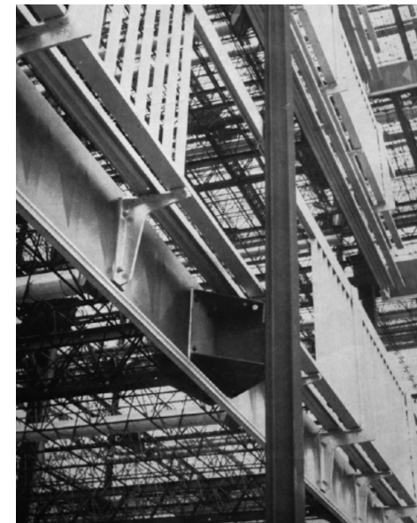
Le système constructif GEAI – La Grand'Mare – Rouen
