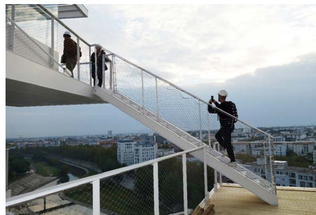
Passerelle entre balcons et bac à plantes-écran, chantier de l'Arbre Blanc à Montpellier - photos P. Lhermet
