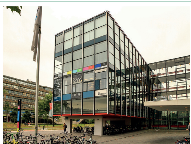
Projet : Façade Leasing pilot project at TU Delft Architecte : T. Klein et al. Date : 2019
